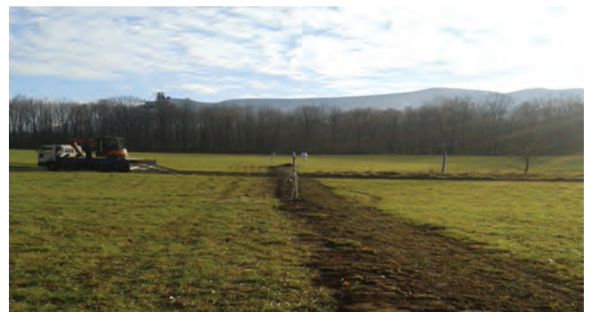
Obr. 7: Stavba systému. Veškerá kabeláž byla umístěna pod zem.
