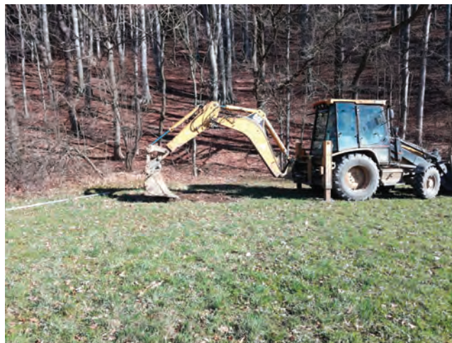
Obr. 18: Zahlazování půdy po odebrání AWS
